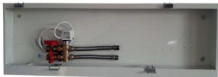
Kondensbricka med 3-vägsventil och avstängningsventiler / Condensate tray with 3-way valve and stop valves
